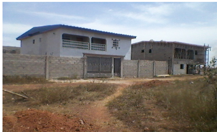
Photo 4 : Construction de maisons en hauteur à Tagoura
